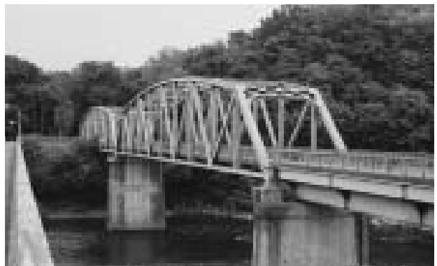
栗谷瀬橋：トラス橋は力強さを感じさせてくれる橋です。
