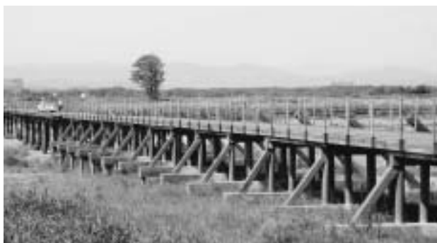
くげ橋：下流に新橋を架橋中です。本橋はまもなく消滅する運命にあります。
