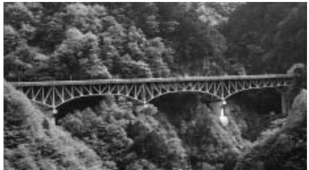
雁坂大橋：彩甲斐街道(国道140号)の最奥の橋です。
