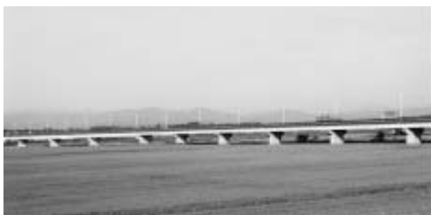
大芦橋：広大な河川敷に20基の橋脚が整然と並んでいます
