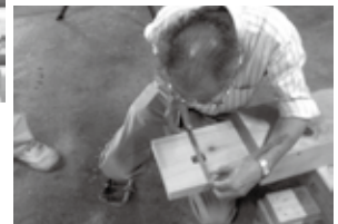
棟梁が図面通りか確認
