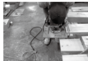
棟梁の指示で穴開け
