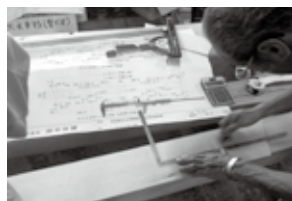
棟梁が図面に合わせて墨入れ
