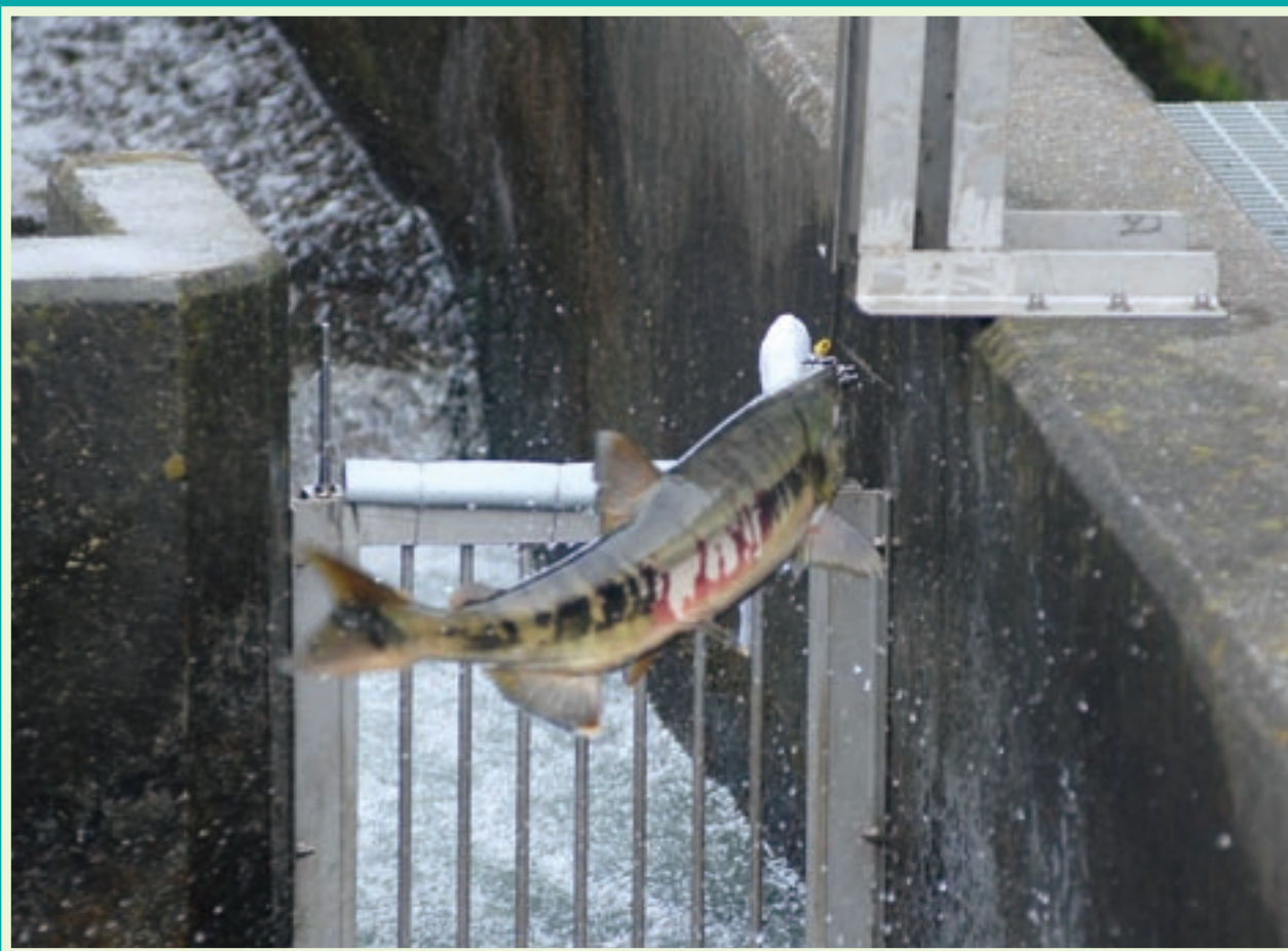
写真 魚道を越えていくシロザケ（利根大堰）
