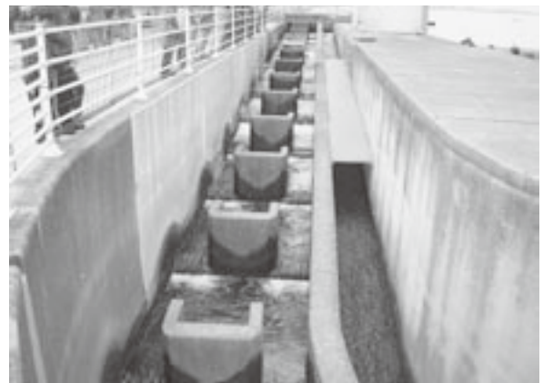
利根大堰魚道(行田市・利根川)
