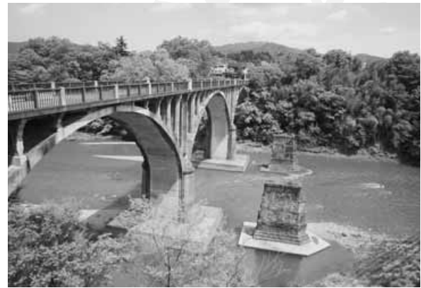
●初代秩父橋の橋脚<右>と旧秩父橋<左>（秩父市） 【この橋の隣に現在の秩父橋と渡し場の跡がある】
