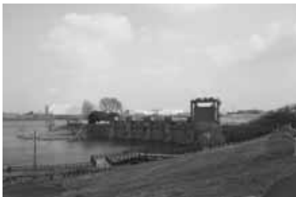
旧岩淵水門（赤水門）（東京都北区志茂）
